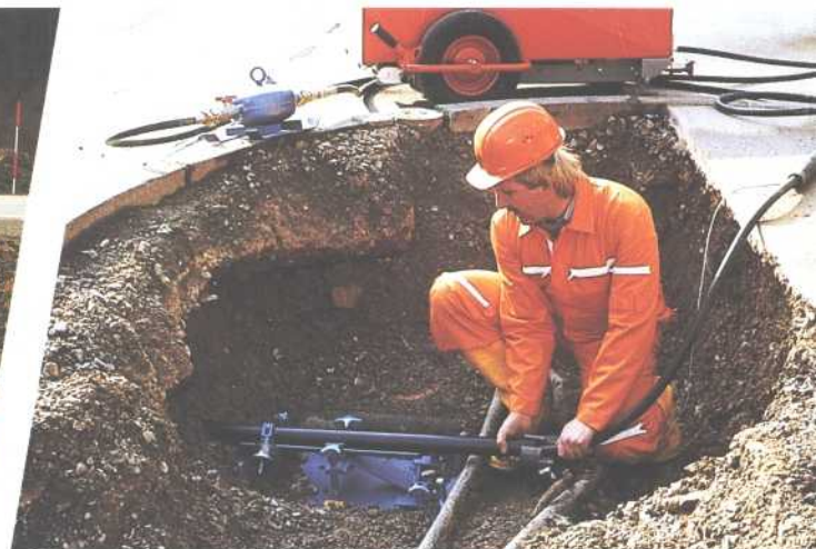
Travaux souterrains dans une ville avec traction directe sans perturbation
