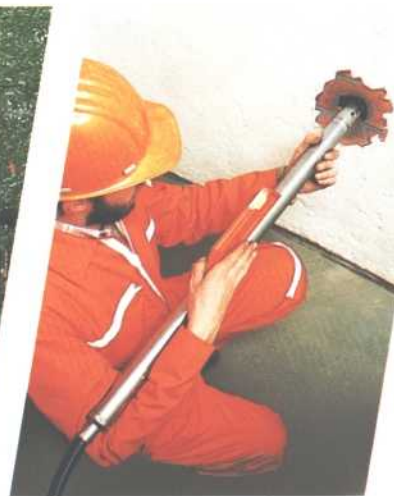
Pose d'une conduite à partir d'une cave
