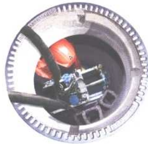
Grundopit - technique de branchement individuel, type regard: DN ≤ 125, 50 m
