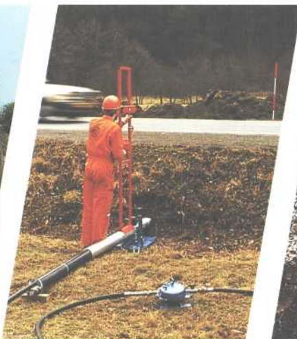
Travaux souterrains sans problème.
