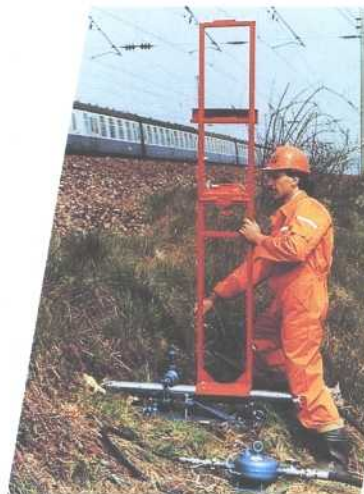
Travaux sous voie ferrée sans perturbation du trafic.
