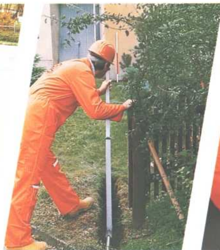
Branchement d'une maison sans détérioration du jardin
