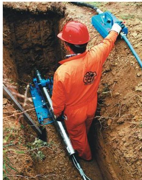
Pour les diamètres importants, Tracto-Techniques a développé le système de pousse-tube pneumatique GRUNDORAM.
